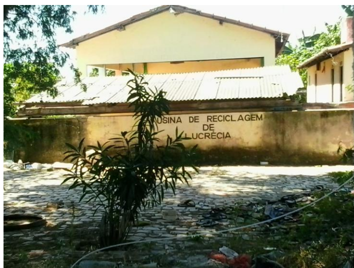
Figura 122: Usina de Reciclagem existente em Lucrécia – RN. Fonte: Equipe BrenCorp, 2015.
