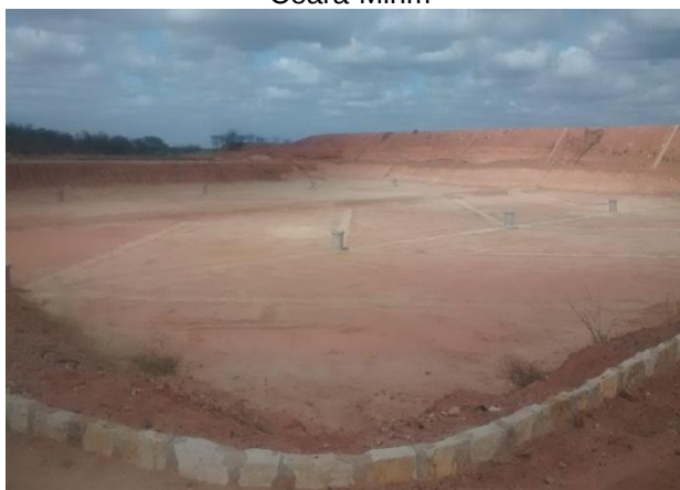
Figura 103: Aterro Sanitário (de pequeno porte) em implantação - Upanema
