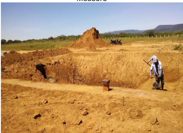
Figura 104: Aterro em valas em implantação - Riacho da Cruz
