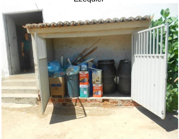
Figura 85: Armazenamento e Acondicionamento de RSS - Campo Grande
