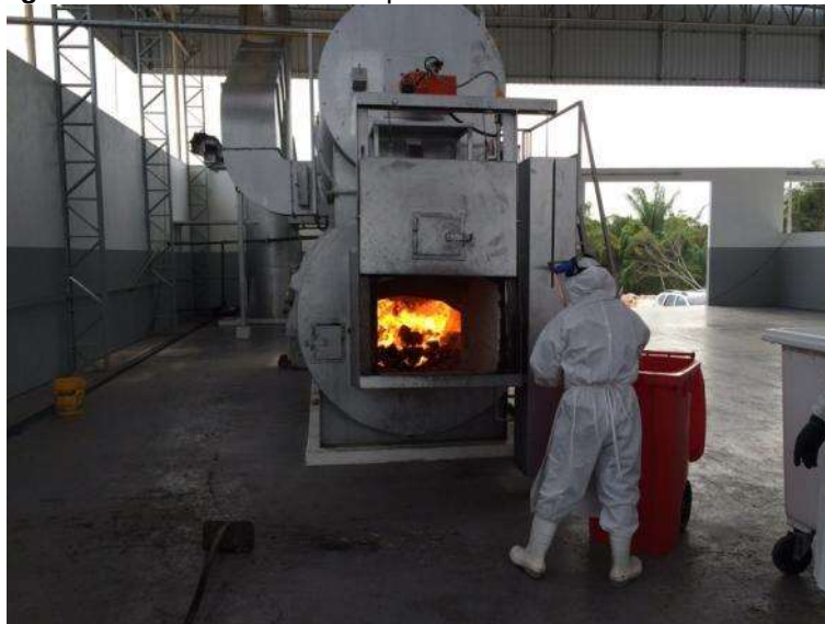
Figura 14 - Incinerador da empresa Norte Ambiental em Iranduba
