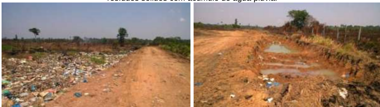
Figura 32 – Deposição inadequada dos resíduos sólidos urbanos e célula para o depósito de resíduos sólidos com acúmulo de água pluvial
