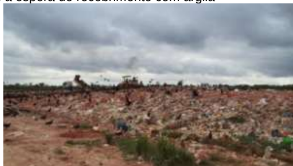
Figura 197 – Resíduos compactados a espera do recobrimento com argila
