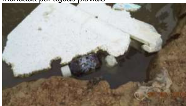
Figura 178 – Vala para RSS inundada por águas pluviais
