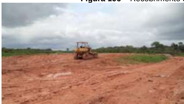
Figura 196 – Recobrimento dos resíduos na área do aterro
