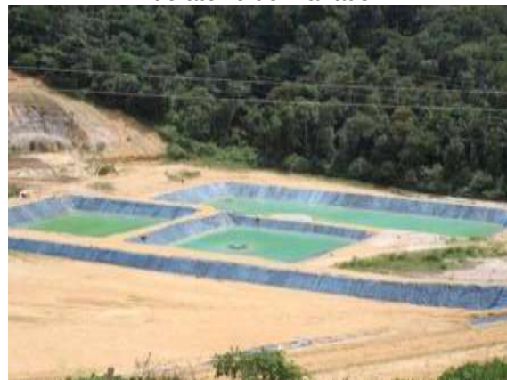
Figura 137 – Lagoas de tratamento de efluentes do aterro de Manaus
