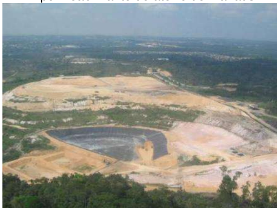
Figura 136 – Vista aérea da manta impermeabilizante do aterro de Manaus
