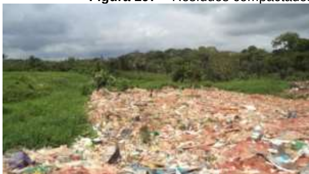
Figura 197 – Resíduos compactados a espera do recobrimento com argila
