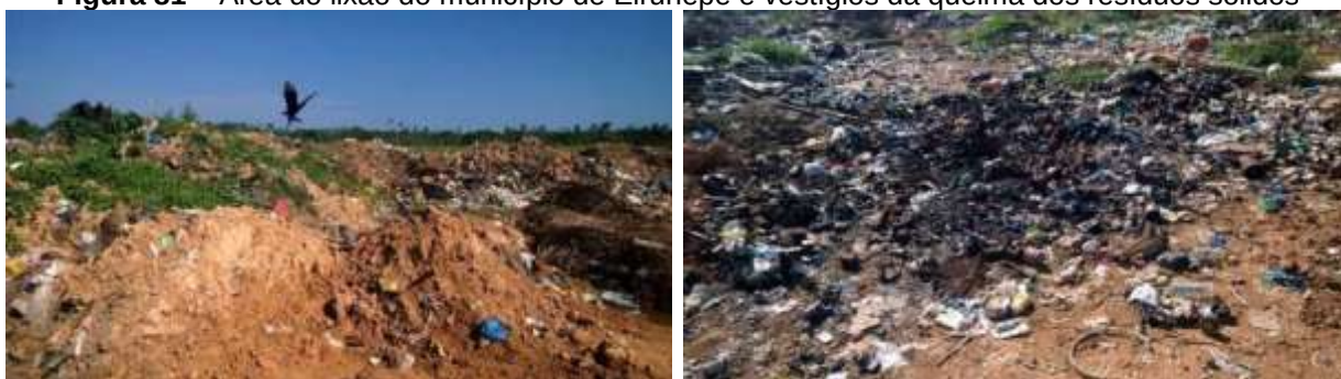
Figura 81 – Área do lixão do município de Eirunepé e vestígios da queima dos resíduos sólidos
