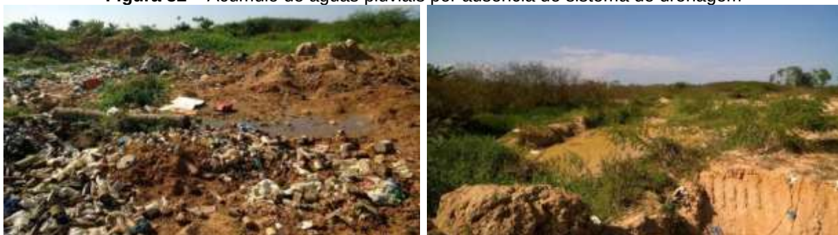
Figura 82 – Acúmulo de águas pluviais por ausência de sistema de drenagem
