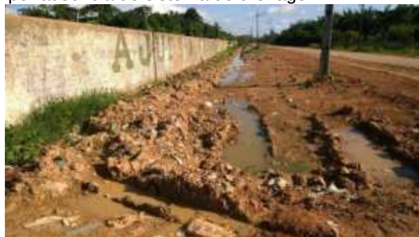
Figura 79 – Acúmulo de águas pluviais por ausência de sistema de drenagem
