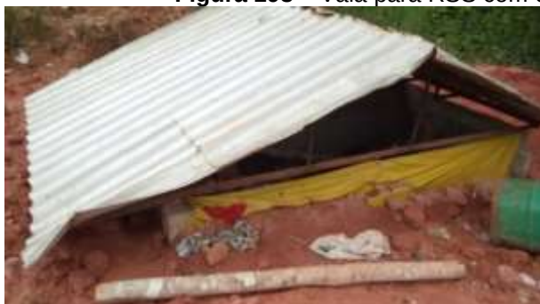
Figura 198 – Vala para RSS com cobertura para proteção conta chuva
