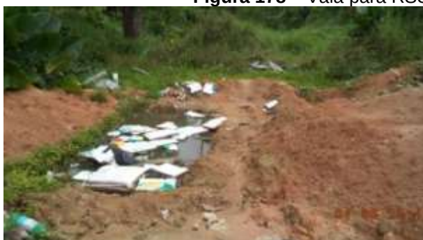
Figura 178 – Vala para RSS inundada por águas pluviais
