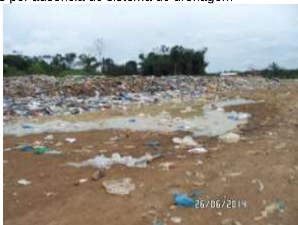
Figura 103 – Acúmulo de águas pluviais por ausência de sistema de drenagem
