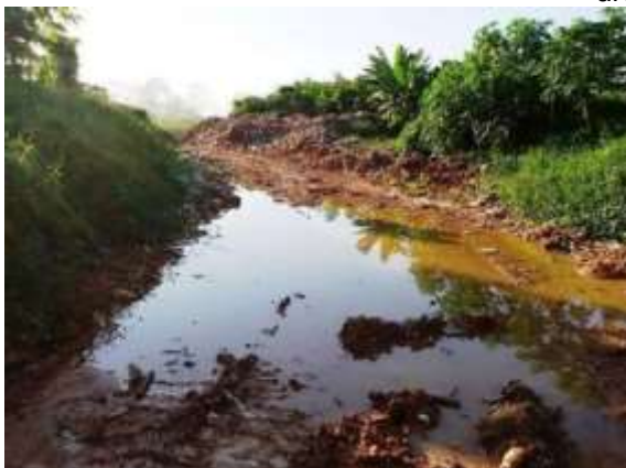
Figura 89 – Acúmulo de águas pluviais contaminada por chorume por ausência de sistema de drenagem
