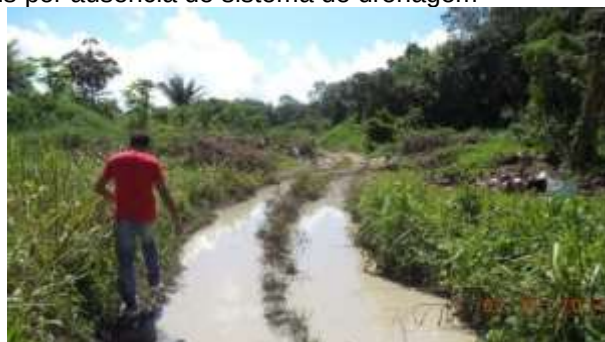
Figura 186 – Retenção de águas pluviais por ausência de sistema de drenagem
