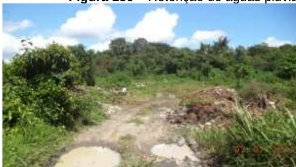
Figura 186 – Retenção de águas pluviais por ausência de sistema de drenagem
