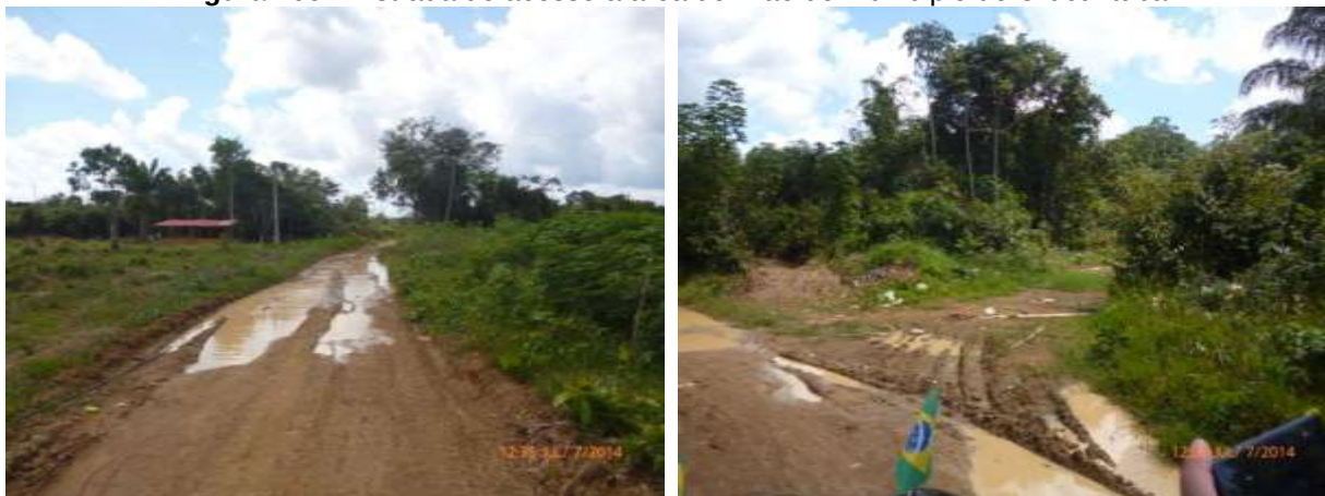
Figura 209 – Estrada de acesso à área do lixão do município de Urucurituba
