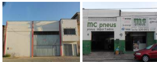
Tabuleiro Martins Galpão Inativo
