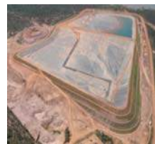
Bacias de rejeitos
