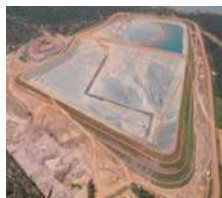
Bacias de rejeitos
