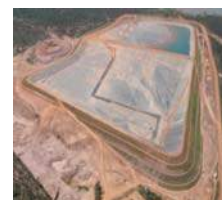
Bacias de rejeitos
