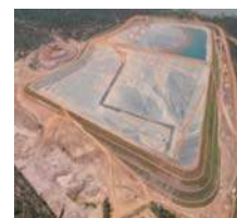
Bacias de rejeitos
