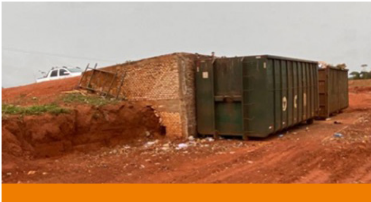
FIGURA 19: Estação de transbordo sem cobertura. Fonte: TCE-MS, 2022.
