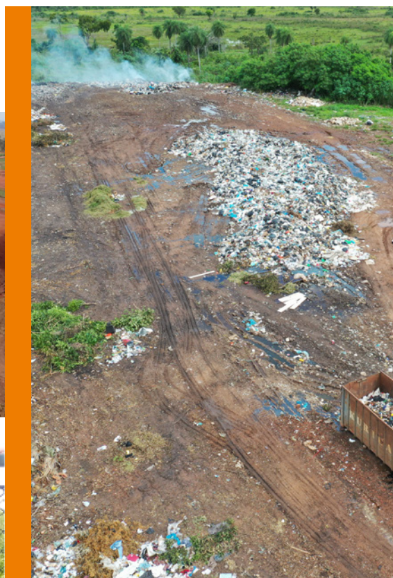
FIGURA 24: Passivo ambiental resultante de disposição inadequada de RSU pendente de recuperação. Fonte: TCE-MS, 2023.
