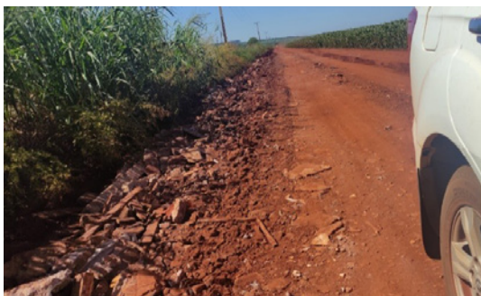
FIGURA 25: Reaproveitamento de RCC na manutenção de estradas vicinais. Fonte: TCE-MS, 2022.
