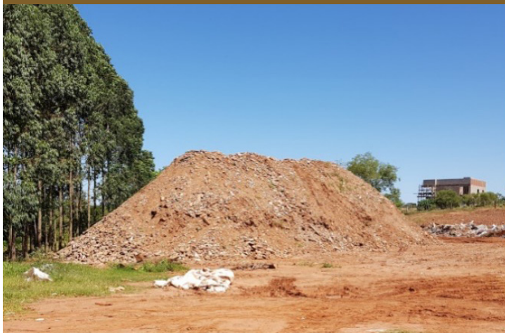
FIGURA 27: Disposição de RCC em aterro licenciado. Fonte: TCE-MS, 2021.
