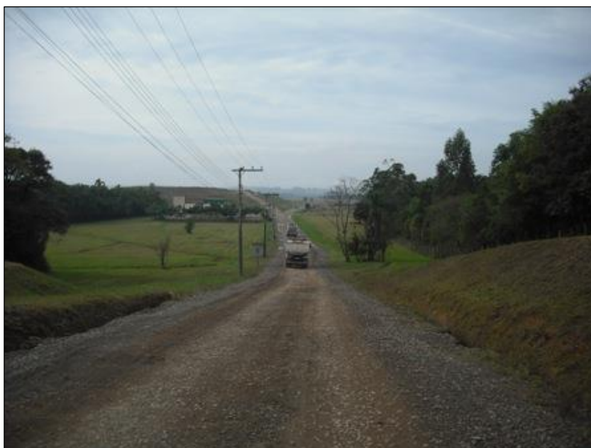
Figura 62 – Vista do aterro de Içara Fonte: Premier Engenharia.
