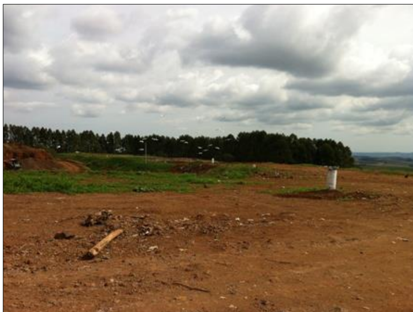
Figura 82 – Vista do aterro de Xanxerê Fonte: Premier Engenharia.
