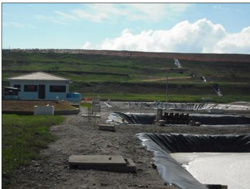
Figura 71 – Vista do aterro de Pescaria Brava Fonte: Premier Engenharia.
