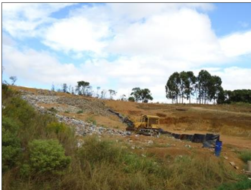
Figura 57 – Vista do aterro de Curitibaanos Fonte: Premier Engenharia.
