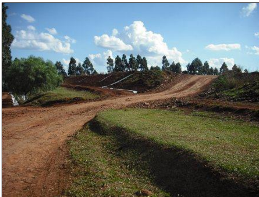
Figura 51 – Vista do aterro de Anchieta Fonte: Premier Engenharia.
