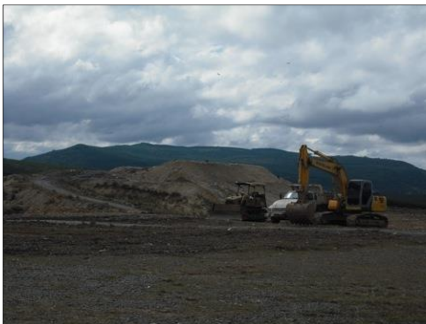
Figura 68 – Vista do aterro de Lages
