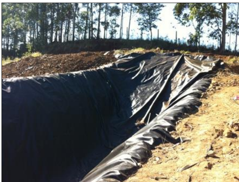
Figura 53 – Vista parcial do aterro de Bom Jesus do Oeste Fonte: Premier Engenharia.
