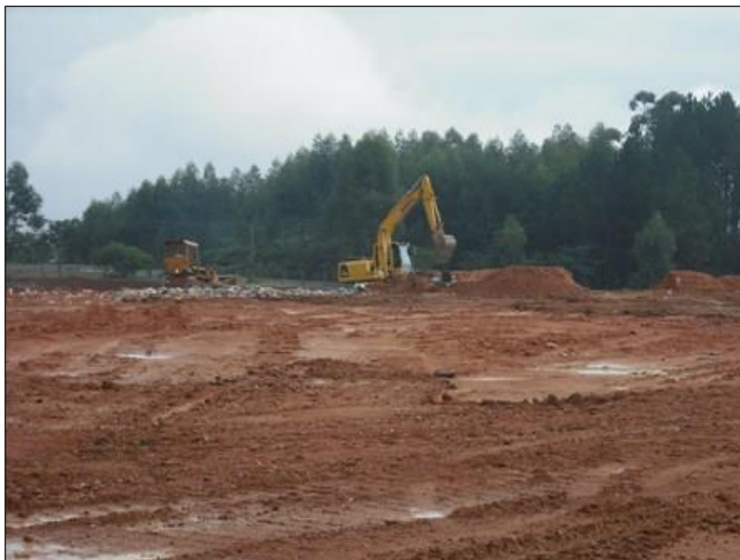
Figura 61 – Vista do aterro de Ibirama
