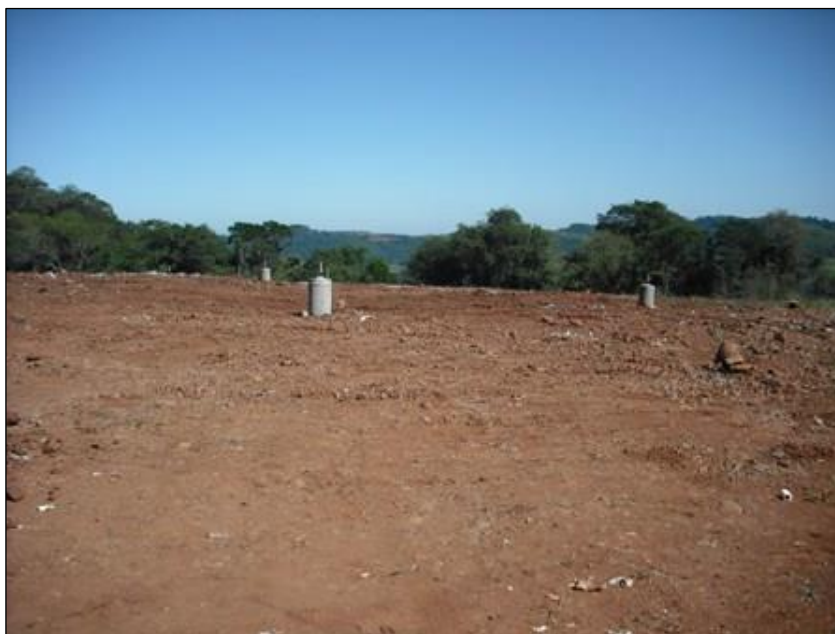
Figura 63 – Vista do aterro de Iporã do Oeste Fonte: Premier Engenharia.
