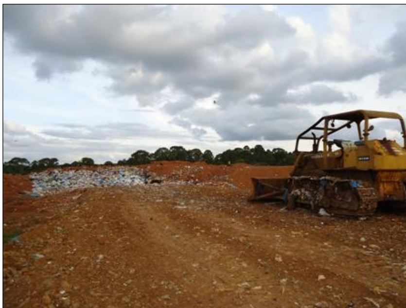
Figura 55 – Vista do aterro de Caçador Fonte: Premier Engenharia.
