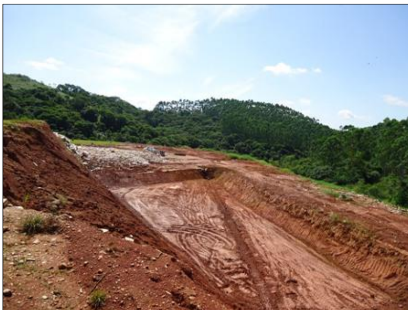
Figura 77 – Vista do aterro de São João Batista Fonte: Premier Engenharia.
