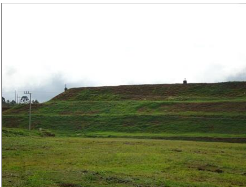
Figura 69 – Vista do aterro de Mafra Fonte: Premier Engenharia.
