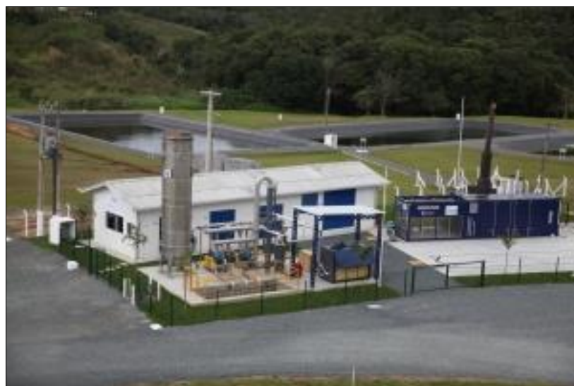
Figura 88 – Usina instalada no aterro de Itajaí Fonte: Agência AL.
