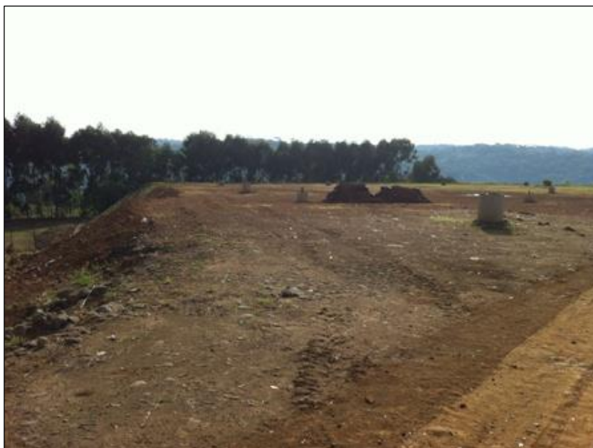
Figura 83 – Vista do aterro de Xaxim
