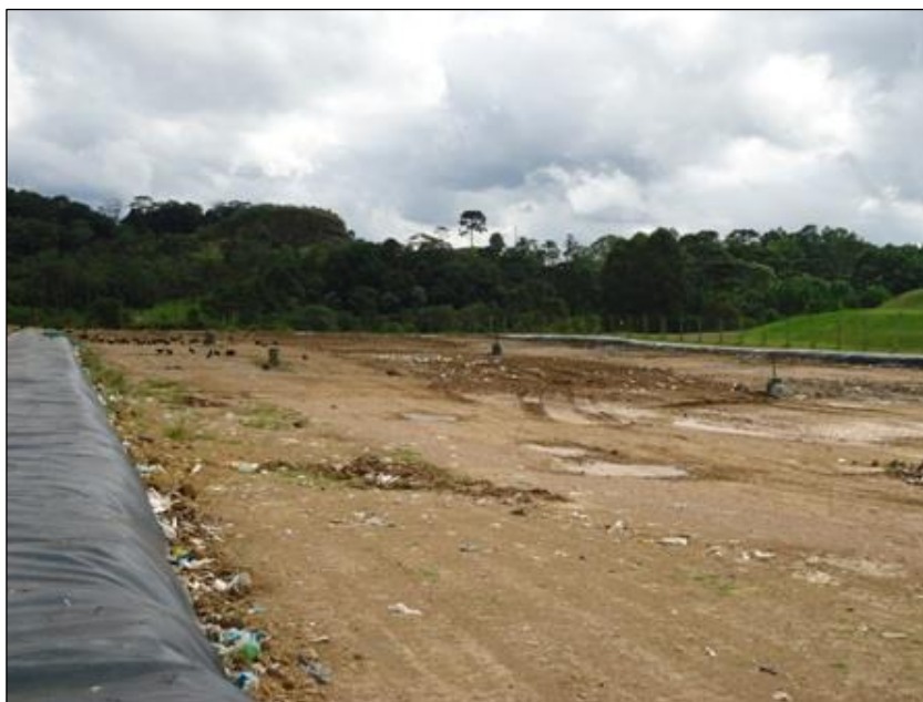
Figura 76 – Vista do aterro de São Bento do Sul Fonte: Premier Engenharia.
