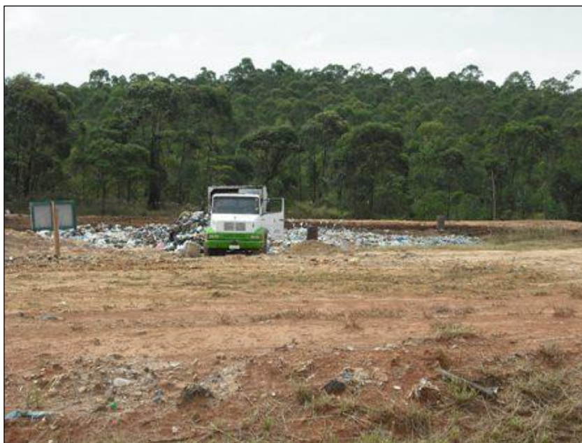
Figura 81 – Vista do aterro de Urussanga Fonte: Premier Engenharia.
