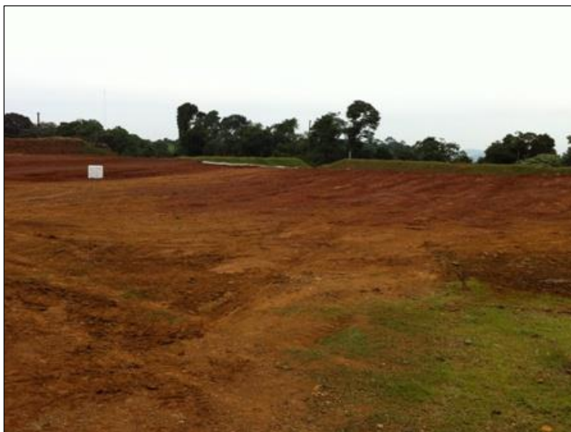
Figura 79 – Vista do aterro de Seara
