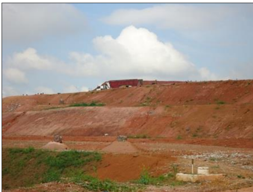
Figura 54 – Vista do aterro de Brusque Fonte: Premier Engenharia.
