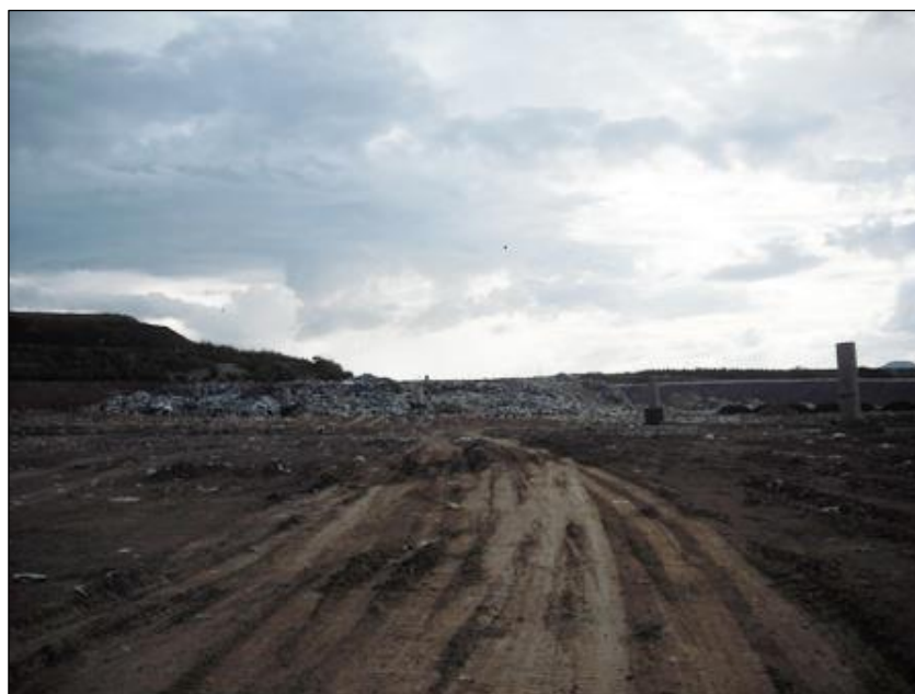
Figura 70 – Vista do aterro de Otacílio Costa Fonte: Premier Engenharia.
